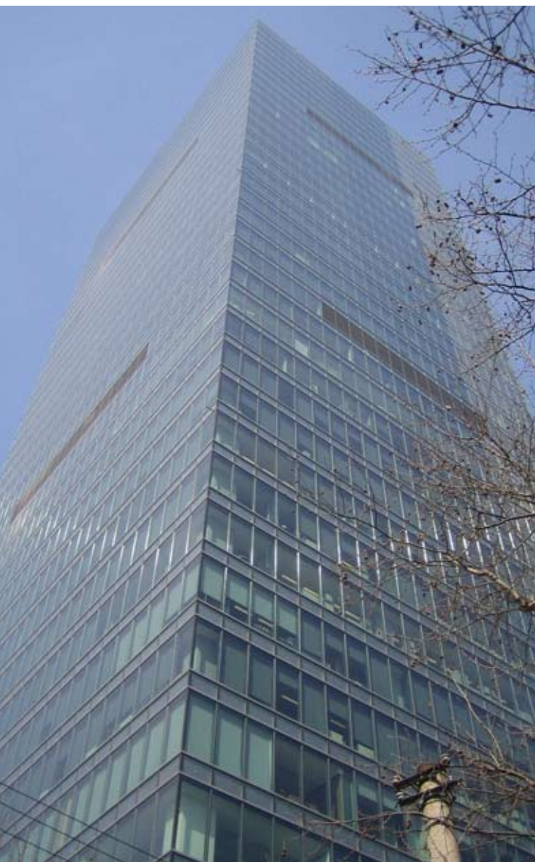
横河電機（中国）商貿有限公司のオフィスビル
